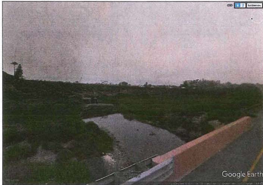
Photo 5. Las Encinas Bridge
